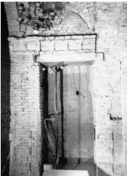
Fig. 4. Chiesa di S. Andrea di Villa Poma (Mantova), interno: particolare dell'inserimento delle architravi lignee nello spessore del pilastro.
