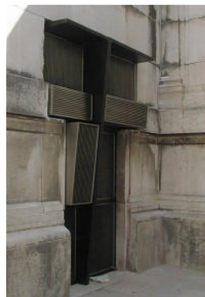
Fig. 19. Nuove griglie di aerazione per immissione/espulsione dell'aria, nel piccolo cortile retrostante uno degli scaloni (sfrutta un'apertura preesistente).
