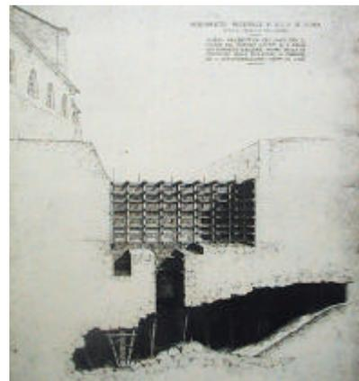
Fig. 5. Veduta prospettica dello scavo per il pilone del portico e della sottostante galleria prima della costruzione delle murature di sottofondazione.
