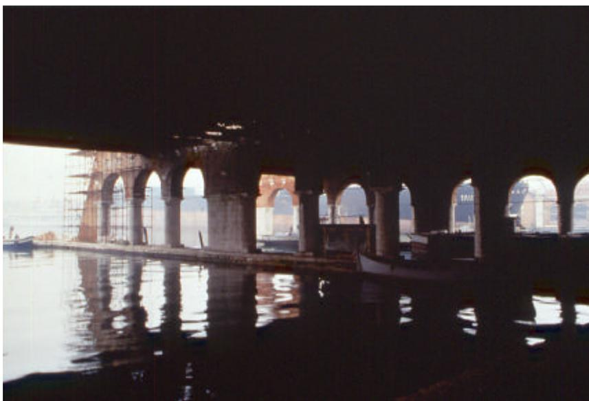
Fig. 2. L'alternanza di pilastri e colonne di imposta delle capriate.
