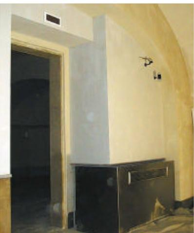
Fig. 16. Struttura in acciaio e cartongesso contenente gli impianti
