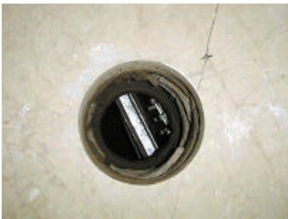
Fig. 20. Realizzazione di foro a pavimento in corrispondenza dei cunicoli esistenti sottostanti per la collocazione delle torri in acciaio.
