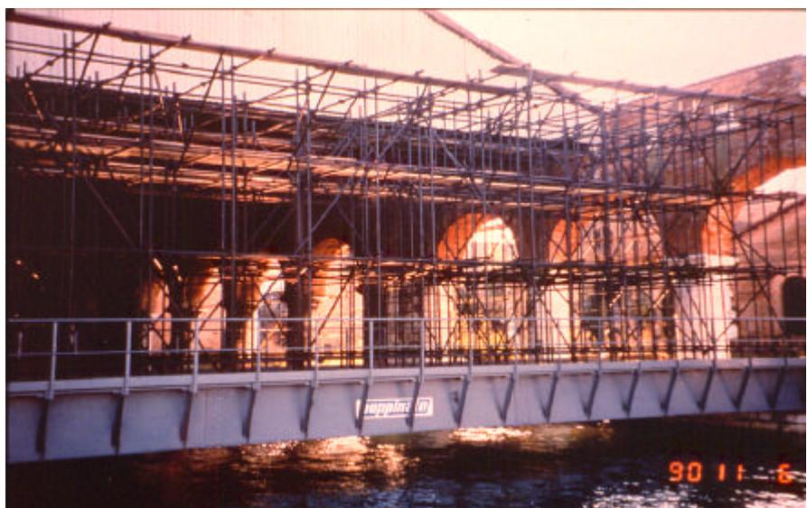
Fig. 10. Posizionamento della piattaforma con i ponteggi sulla testata delle banchine della prima "tesa".
