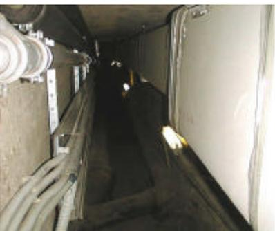
Fig. 13 - 15. Canalizzazioni e componenti tecnici che sfruttano le gallerie esistenti per l'adduzione di aria trattata negli ambienti ciechi al pianterreno.
