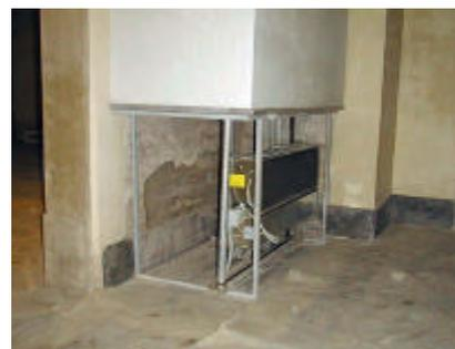
Fig. 17. Fan-coil all'interno della struttura in acciaio e cartongesso.
