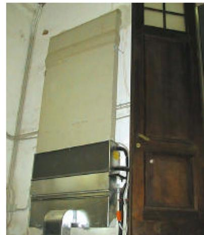
Fig. 18. Fan-coil collocato nell'ambiente con le pompe per la fontana che, mediante due griglie nel muro, fornisce aria trattata nell'ambiente museale retrostante.
